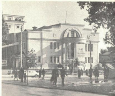
Здание театра «Красный фанел» — бывший Дом революции
